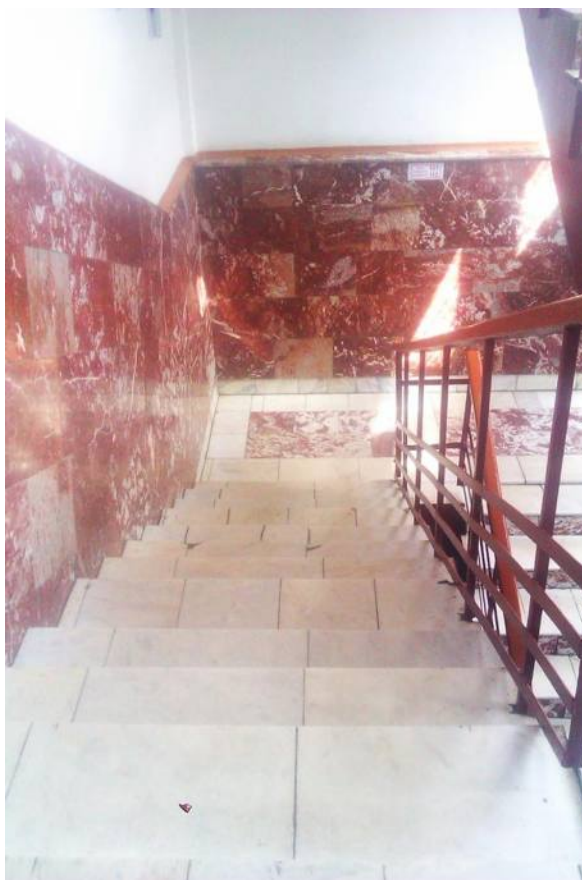
Фото 14. Лестница (внутри здания)
