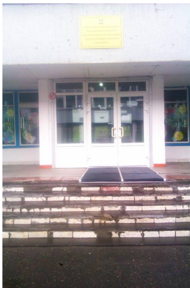
Фото 8. Входная площадка перед дверью
