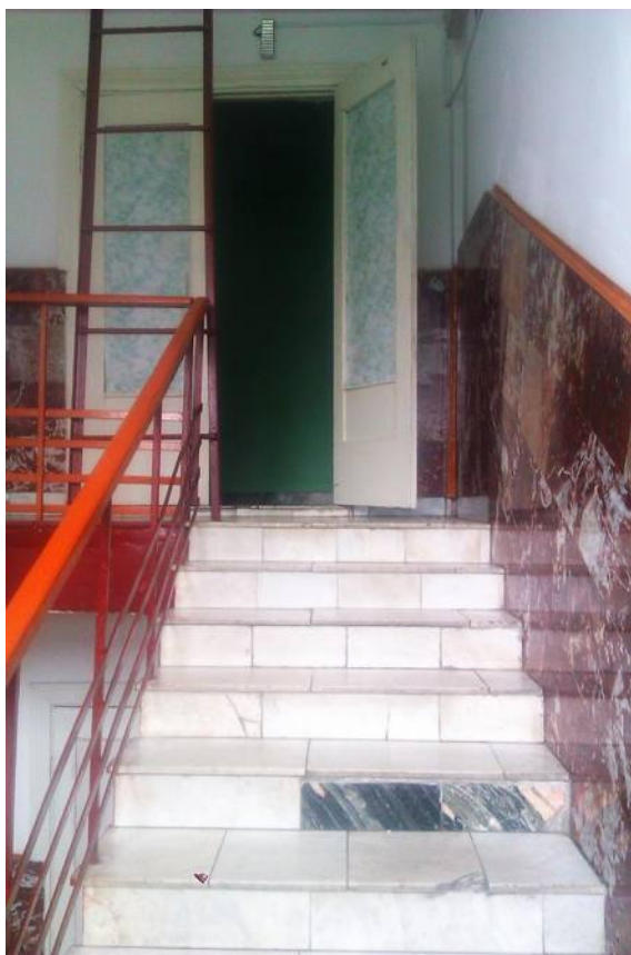
Фото 13. Лестница (внутри здания)
